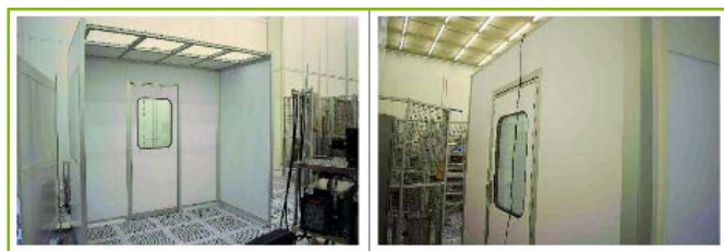
▲ FIGURA 8 - MOCK-UP NELLA SALA TEST
